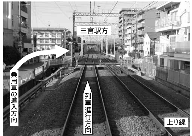
写真2 列車からの本件踏切の見通し状況
