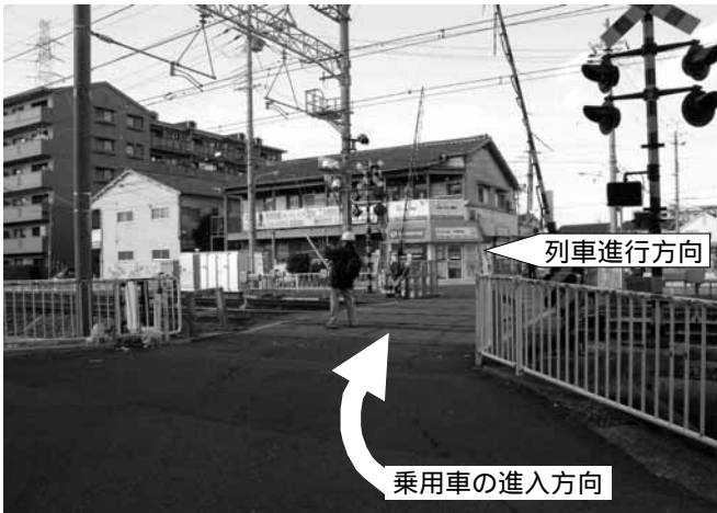
写真1 本件踏切の状況
