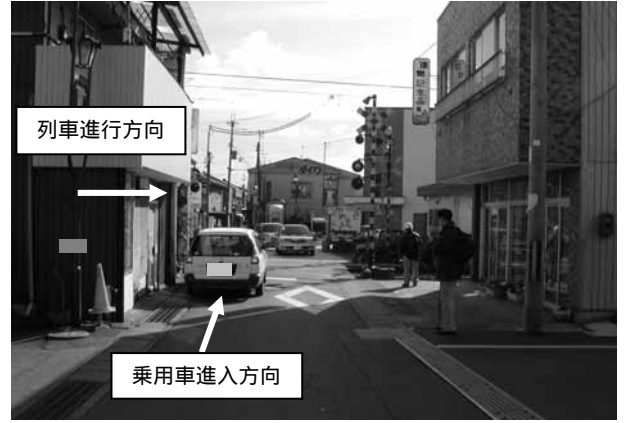
写真2 道路側から見た踏切の見通し状況
