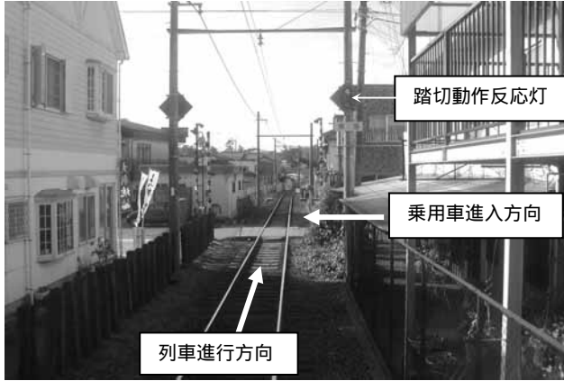
写真1 列車側から見た踏切の見通し状況
