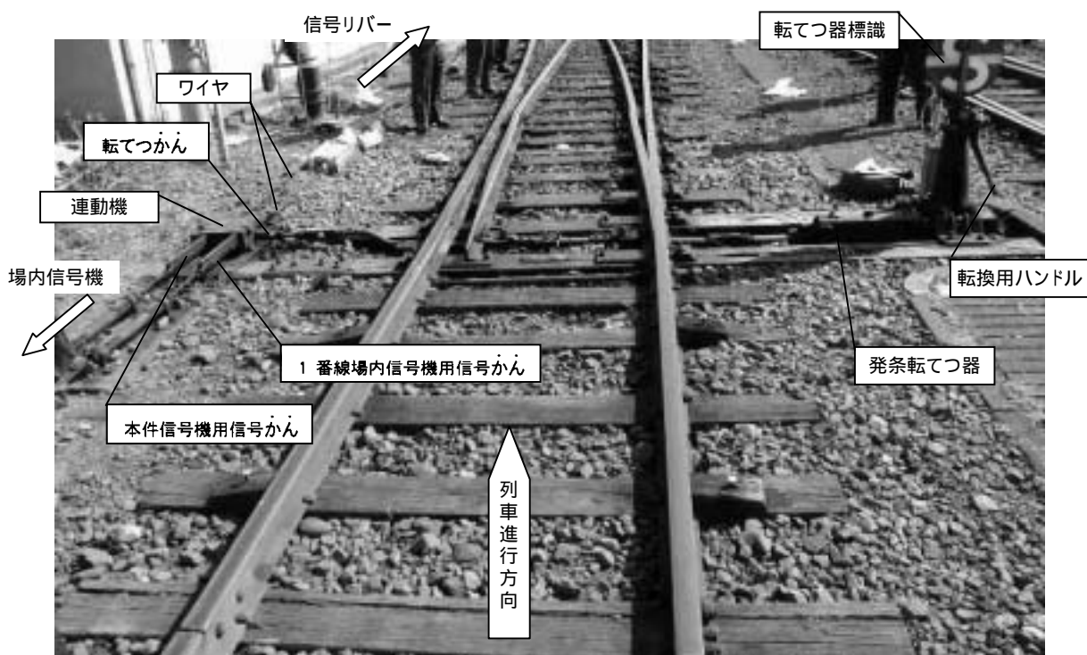
(下り本線側進入時)
