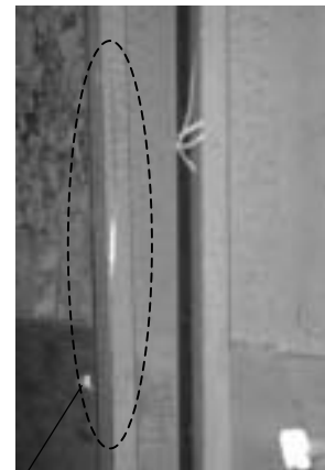
右リードレール頭頂面から右側面に痕跡(落輪)
