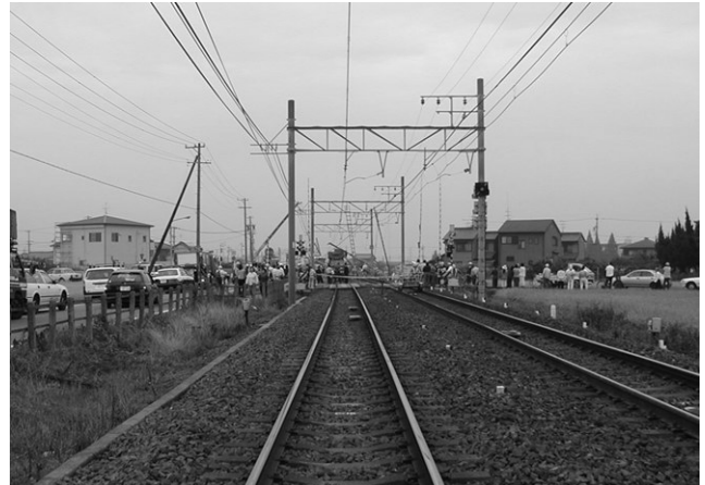
写真2 列車から本件踏切の見 通し状況
