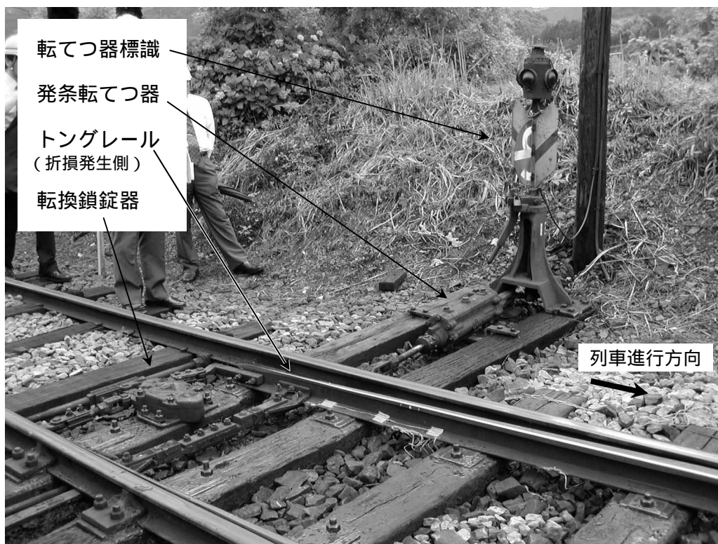
写真4 発条転てつ器の設置状況 (トングレール交換後)
