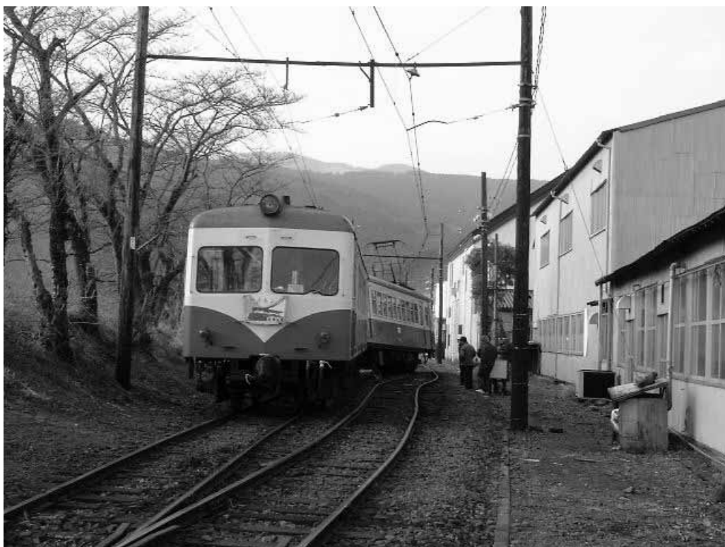
写真2 事故現場の状況（本件列車後方より）
