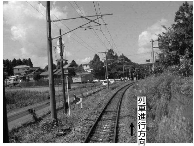
写真2 本件踏切の見通し状況 (約100m手前より)
