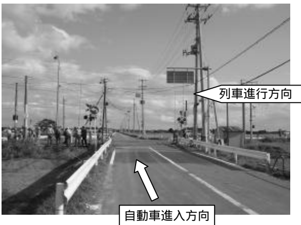
写真5 自動車進入側から本件踏切の見通し状況
