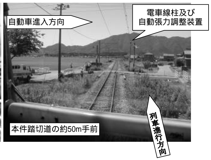
写真6 列車からの踏切道見通し状況
