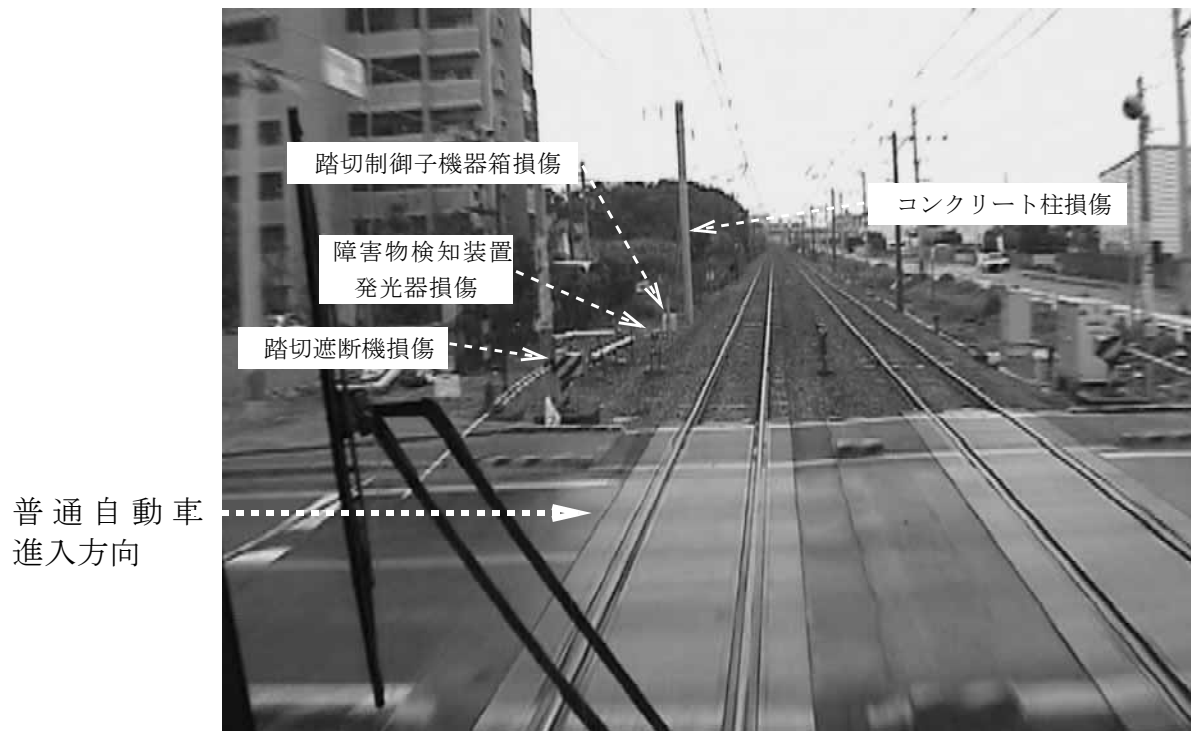
写真4 下り列車から本件踏切直前の見通し状況
