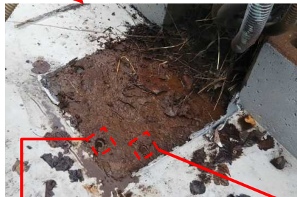
コンクリート躯体の表面の状況
