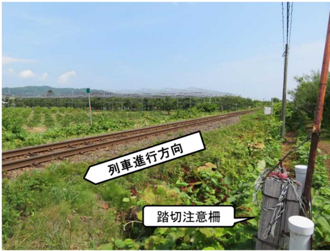
< 歩行者進入側から見た列車の見通し状況 >
