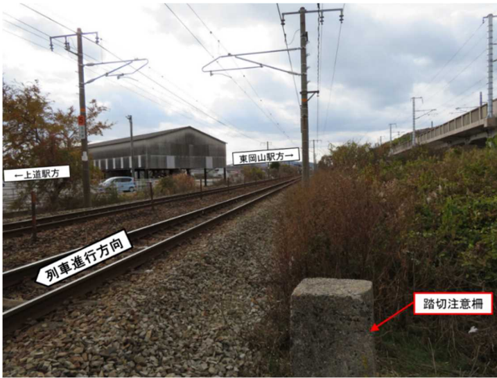
< 歩行者進入側から見た列車見通し状況 >
