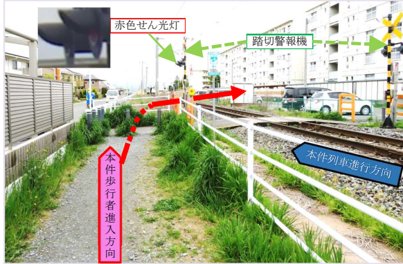
＜本件歩行者進入側から見た本件踏切の状況＞
