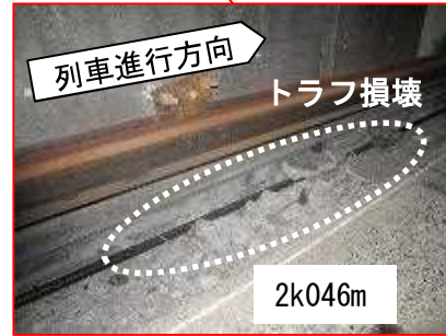
案内軌条緊締装置の破損
