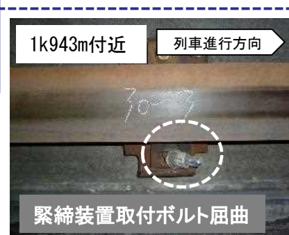
案内軌条緊締装置の破損
