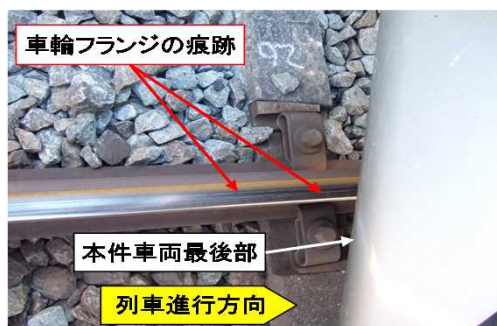
② 本件車両後方の外軌の痕跡
