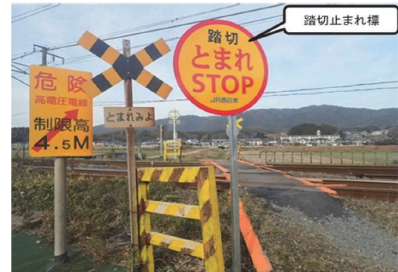
図 JR西日本による安全対策実施
