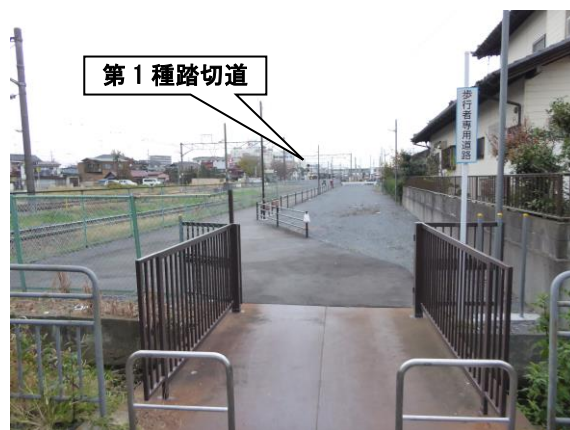
第4種踏切道跡から見た迂回路 (鉄道事業者の所有地を借上げ)
