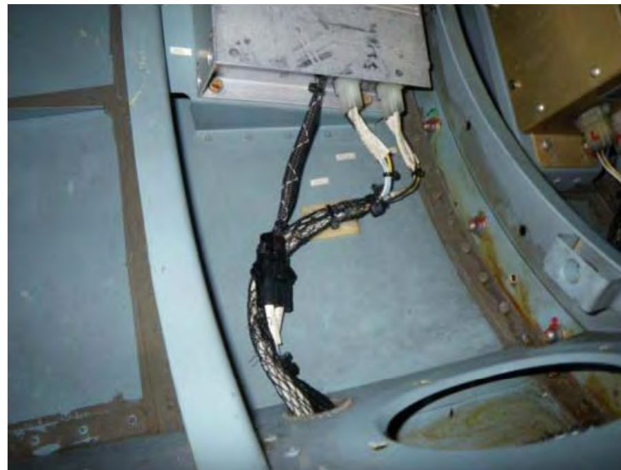
写真8 配線の状況(同型機)
