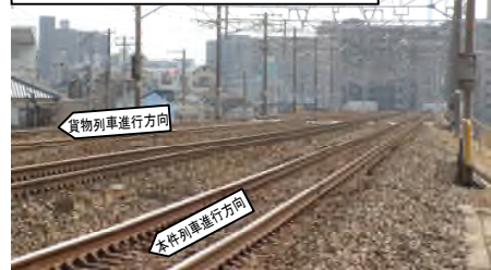
事故現場付近からのB駅方見通し状況
