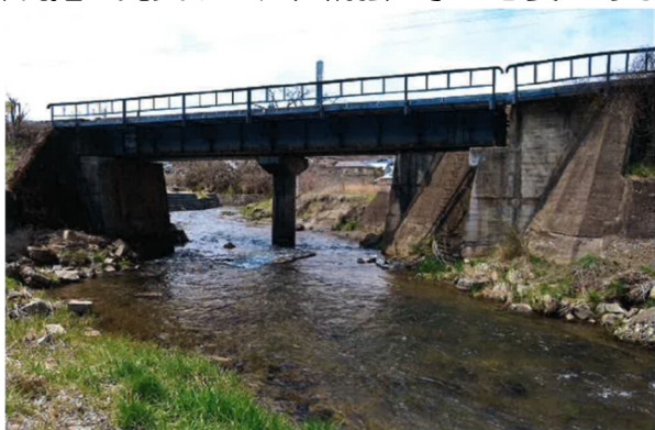
図17 第4北上川橋梁（上流側より全景）
