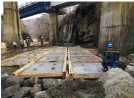
図2-1 護床ブロック新設 (コンクリート打設完了)
