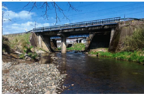
図18 第4北上川橋梁（下流側より全景）
