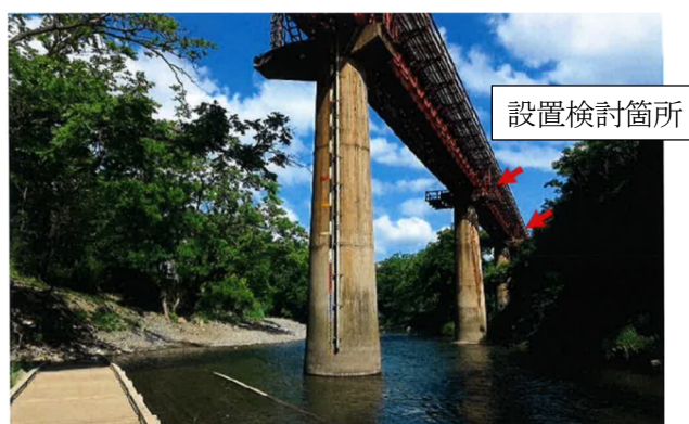
図20 第10馬淵川橋梁（下流側より全景）
