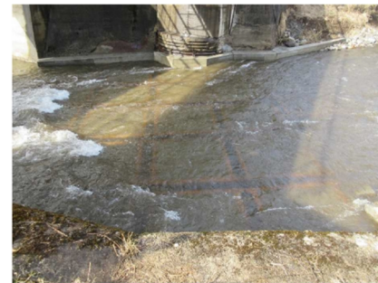
図2-3 施工完了(河床底面)
