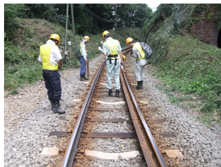
「現地調査」の様子
