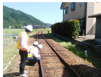
「現地調査」の様子
