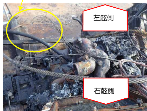
被覆が焼けた状態の電気配線
