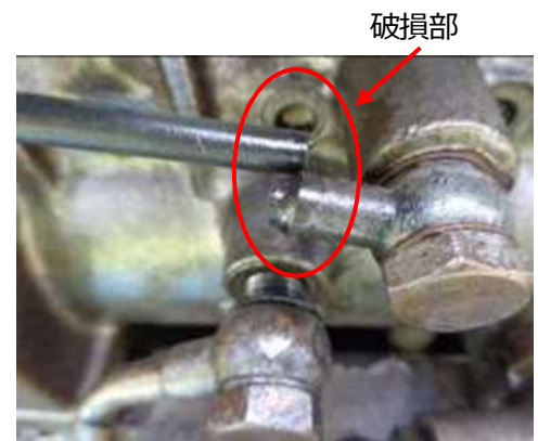
本件パイプの取付け状況
