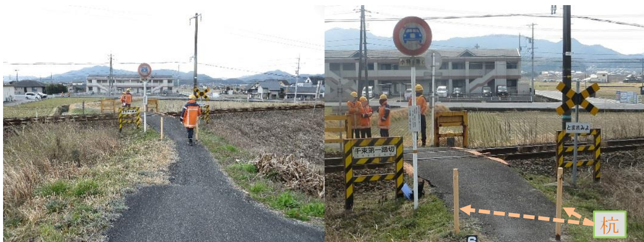
写真1 自転車進入側から見た踏切の状況
