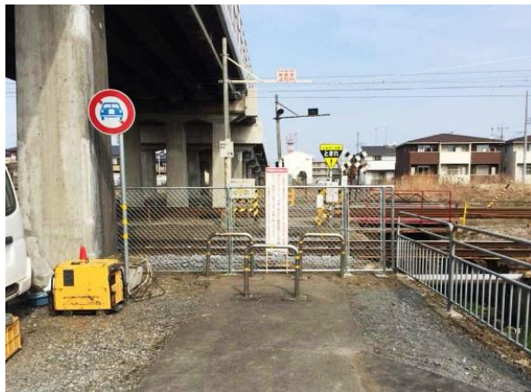
廃止された第4種踏切道 (3鉄道事業者3路線 また を跨いでいた)
