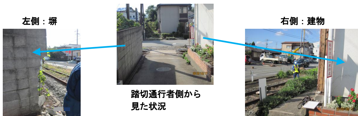
踏切の見通しが近接の建物や塀等で遮られている例
