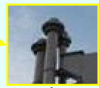
スロップタンクの排気管放出口
