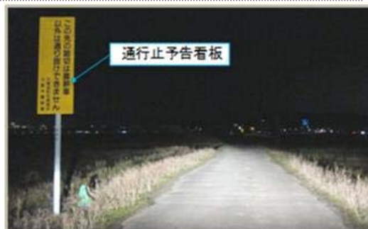
本件道路途中の通行止予告看板と路肩の状況
