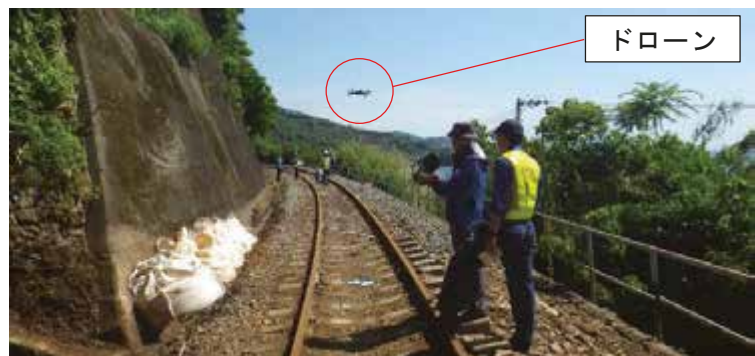
ドローンによる撮影状況
