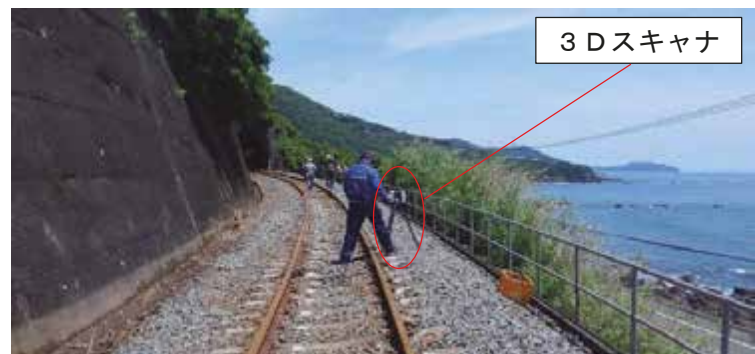
3Dスキャナによる撮影状況
