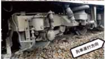
第5軸及び第6軸の脱線状況
