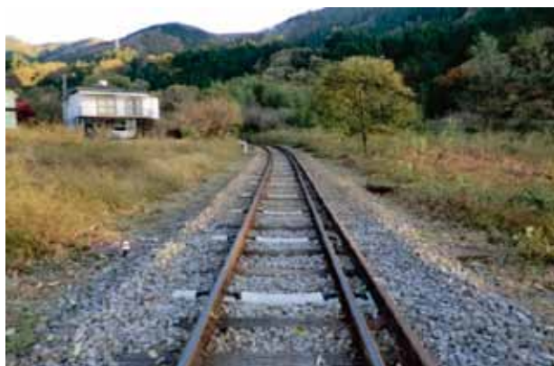
図8 部分PCまくらぎ交換の例
