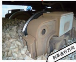
車止めの砂利盛りに埋まった第1軸(左側)
