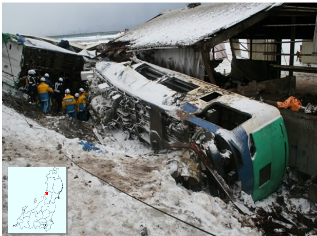
脱線車両の状況
