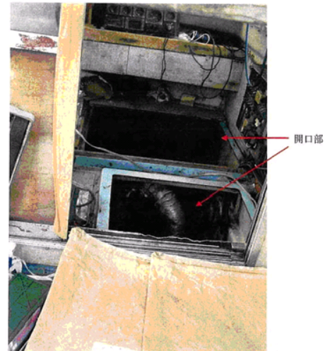
機関室上部の開口部
