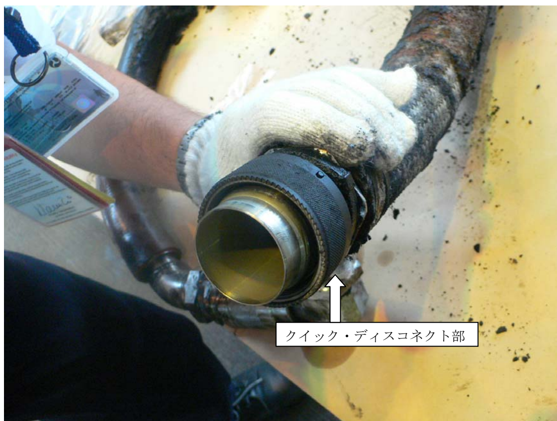
写真6 燃料供給ホース接続部(差し込み部)
