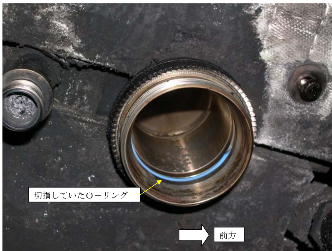
写真5 燃料供給ホース接続部(受け部)
