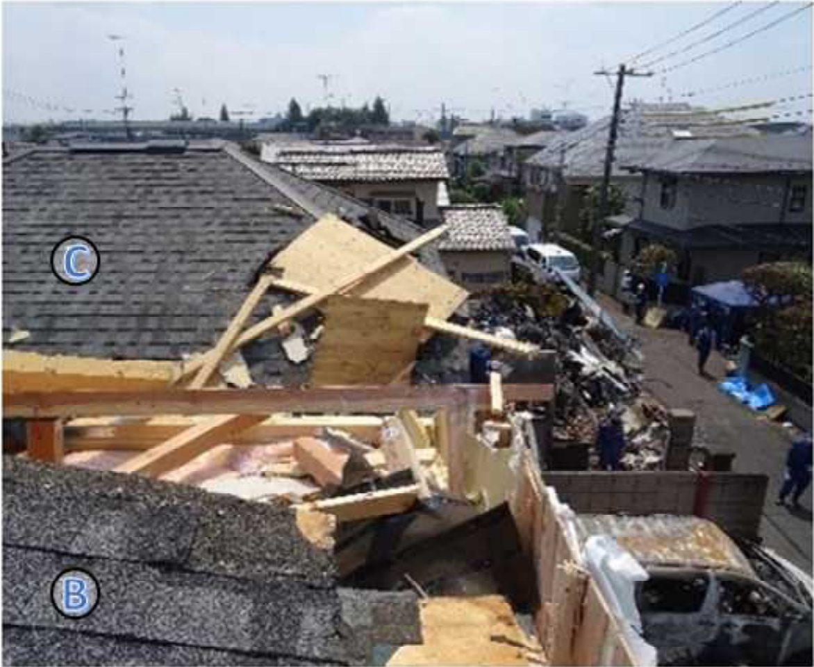
写真2.4.2-3 住宅Bの破損した屋根及びその屋根材が散乱した住宅C
