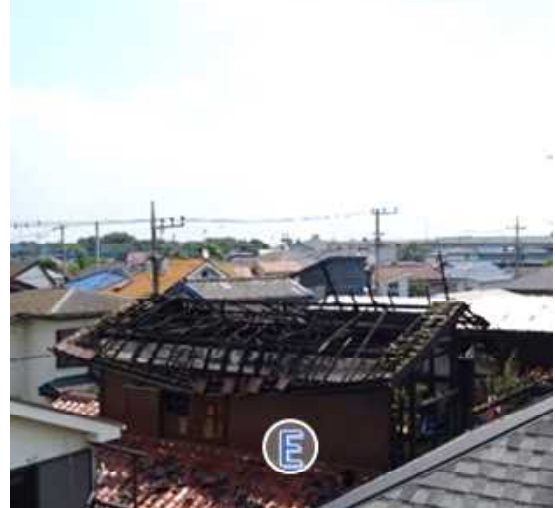
写真2.4.2-6 住宅Eの焼損状況
