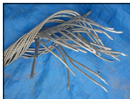
(写真3 電力線の破断部)
