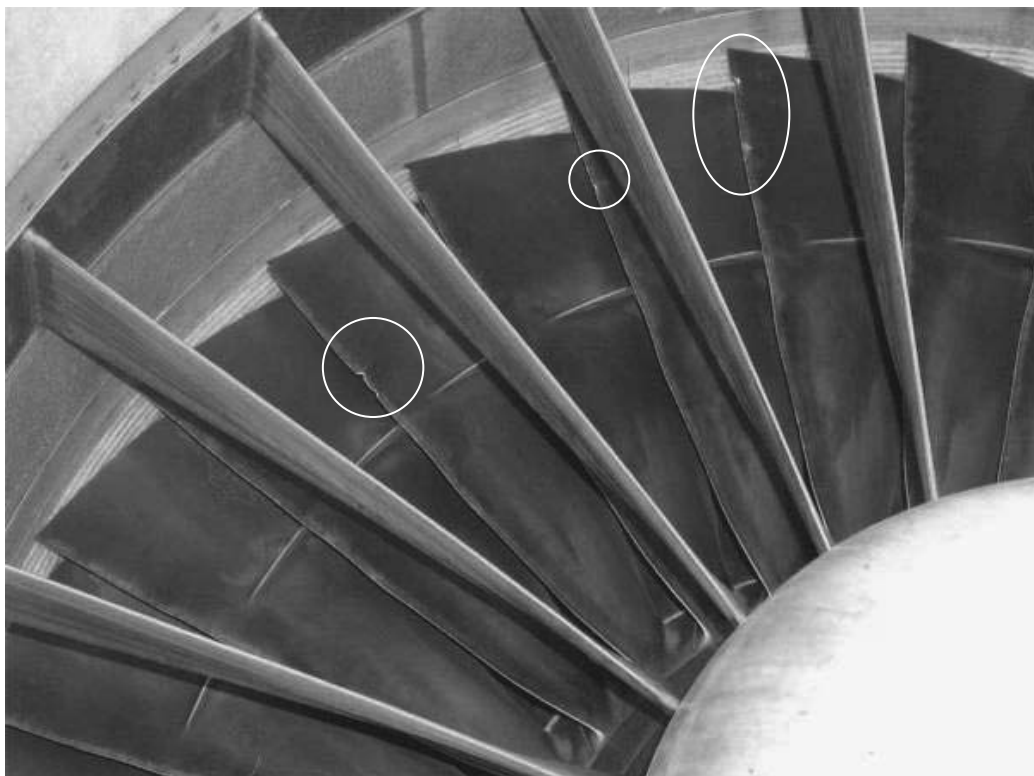
写真7 ファン・ブレードの打痕
